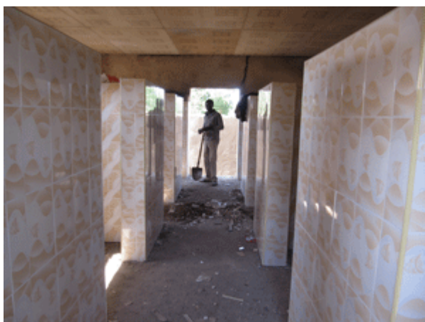
L'intérieur : 6 salles de bains avec 5 douches dans chacune
