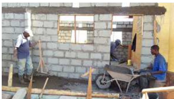
Construction de la "nursary class" à Lemongo primary pour les 4-6 ans.
