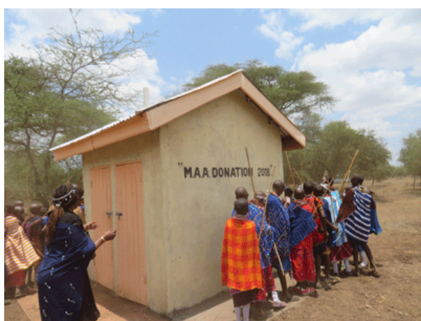
Les 4 latrines construites par MAA.
